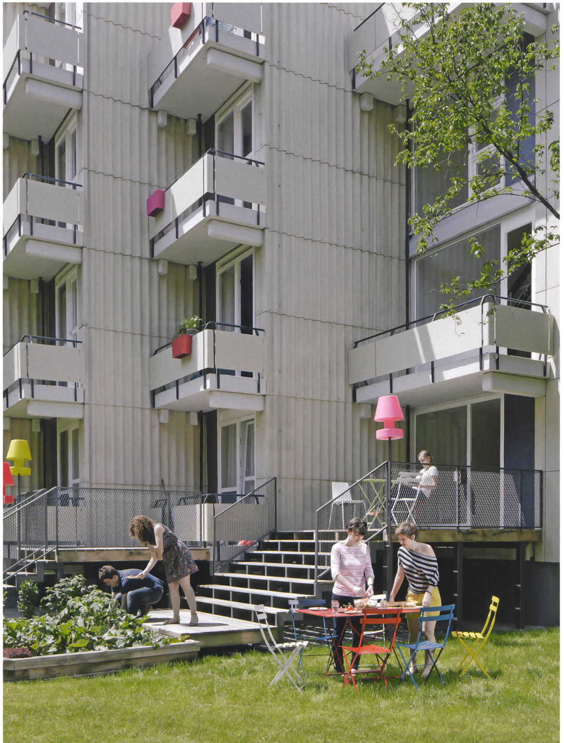
Von allen erdgeschossigen Wohneinheiten sind nun die Freiräume direkt erschlossen. Im Haus 13 ( Haus für urbane Gartenfreunde ) liegen Kräuterbeete vor den Gemeinschaftsküchen. Bild: NOSHE
