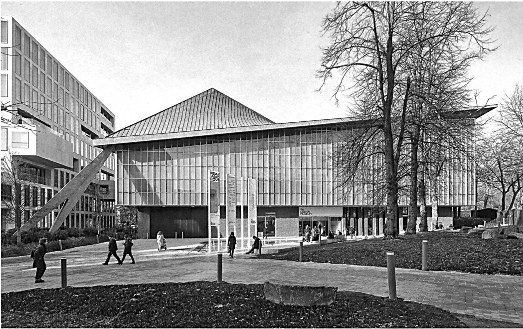
Das 1962 vom Büro RMJM entworfene Commonwealth Institute mit seinem diagonal aufgesetzten hyperbolischen Paraboloid der Dachschaale baute John Pawson zum neuen Design Museum um. Bild: Hufton + Crow
