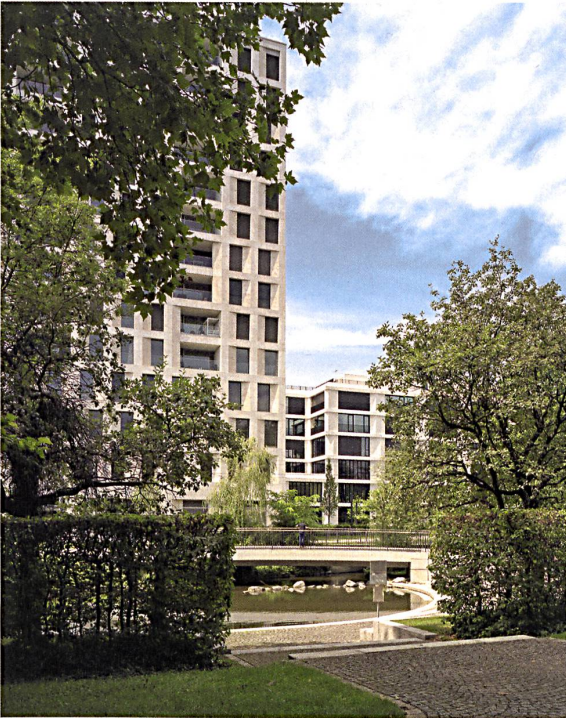
Der nördliche Bauabschnitt ist seit 2016 fertig. Die grüne Umgebung am freigelegten Bachlauf und der eindrucksvolle Baumbestand an der Berliner Strasse zur Ostseite prägen das Bild.
