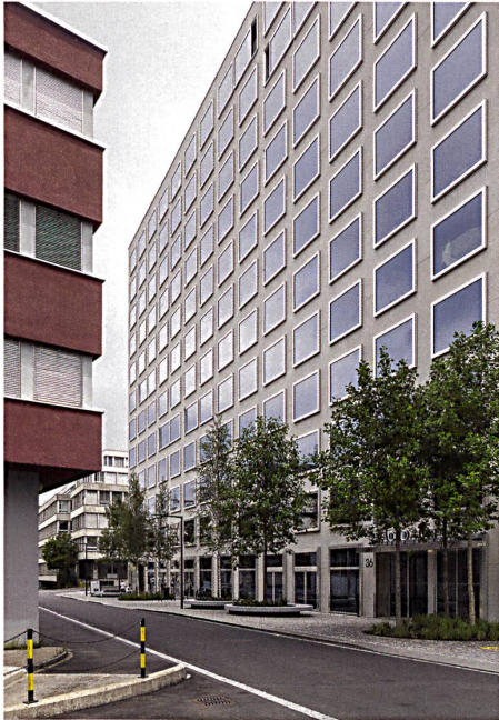
Hinter dem neutralen Fassadenraster der Diakonie Bethanien in Zürich-Altstetten bringen E2A Architekten ein Programm für ein halbes Quartier unter. → S. 30 Bild: Georg Aerni
