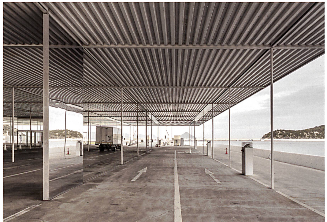
Ein grosses Dach überdeckt am Fährhafen in Naoshima den von Fussgängern und Fahrzeugen geteilten Raum, ohne Hierarchie. Bilder: Rasmus Hjørtshøj – COAST
