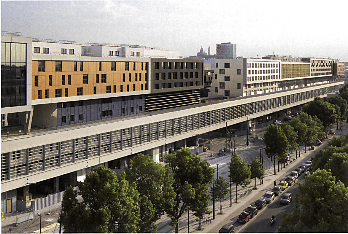
Auf der Nordseite, am Boulevard Macdonald ist das 650 Meter lange Lagerhaus noch gut zu erkennen; die neuen Aufbauten mussten sich zur Straße hin an bestimmte Gestaltungsregeln halten. Bild: Eric Sempé
