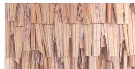
Palmenblätter: Das Material eignet sich durch seine hohe Wärmedämmfähigkeit und Wasserdichtigkeit gut zur Dacheindeckung.
