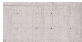
Beton: Das industrielle Material verleiht der Tragstruktur die nötige Erdbeben- und Brandsicherheit.
