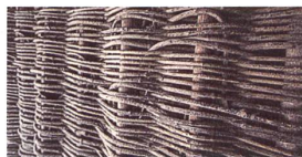
Liane: Die sehnige Kletterpflanze wird zur Befestigung des Deckmaterials an der Dachstruktur verwendet.
