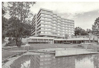
Bruno Buri Sanierung und Erweiterung Pflegezentrum Tilia, Köniz, 2010–17 Schär Buri Architekten, Bern Bild: Christine Blaser
