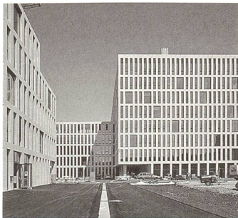
Pascal Vincent Verwaltungszentrum Guisanplatz Bern, im Bau Aebi & Vincent Architekten, Bern und Carouge Bild: Thomas Telley
