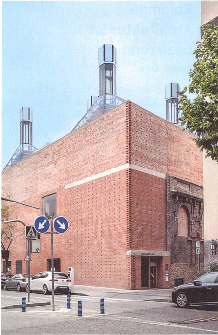
Vier schlanke Kamine lassen die Luft aus dem Kulturzentrum Cristeries Planell in Barcelona abziehen und setzen zugleich ein unverwechselbares Zeichen, entworfen von H Arquitectes. → S. 13. Bild: Adrià Goula
