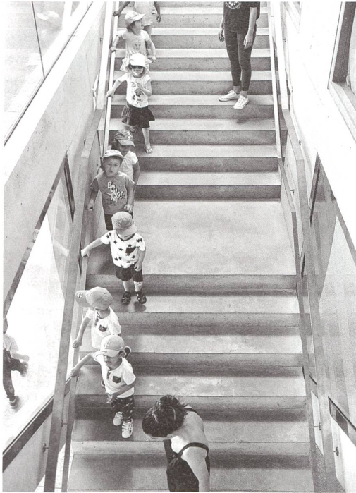
Détail de l'escalier central
