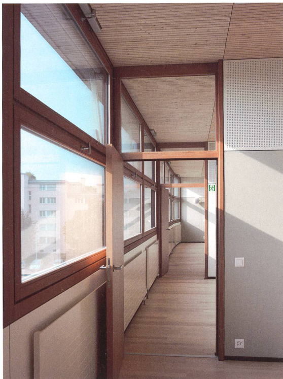
Enfilade entlang der Fassade: Alle inneren Ausbauten sind in Leichtbauweise ausgeführt.
