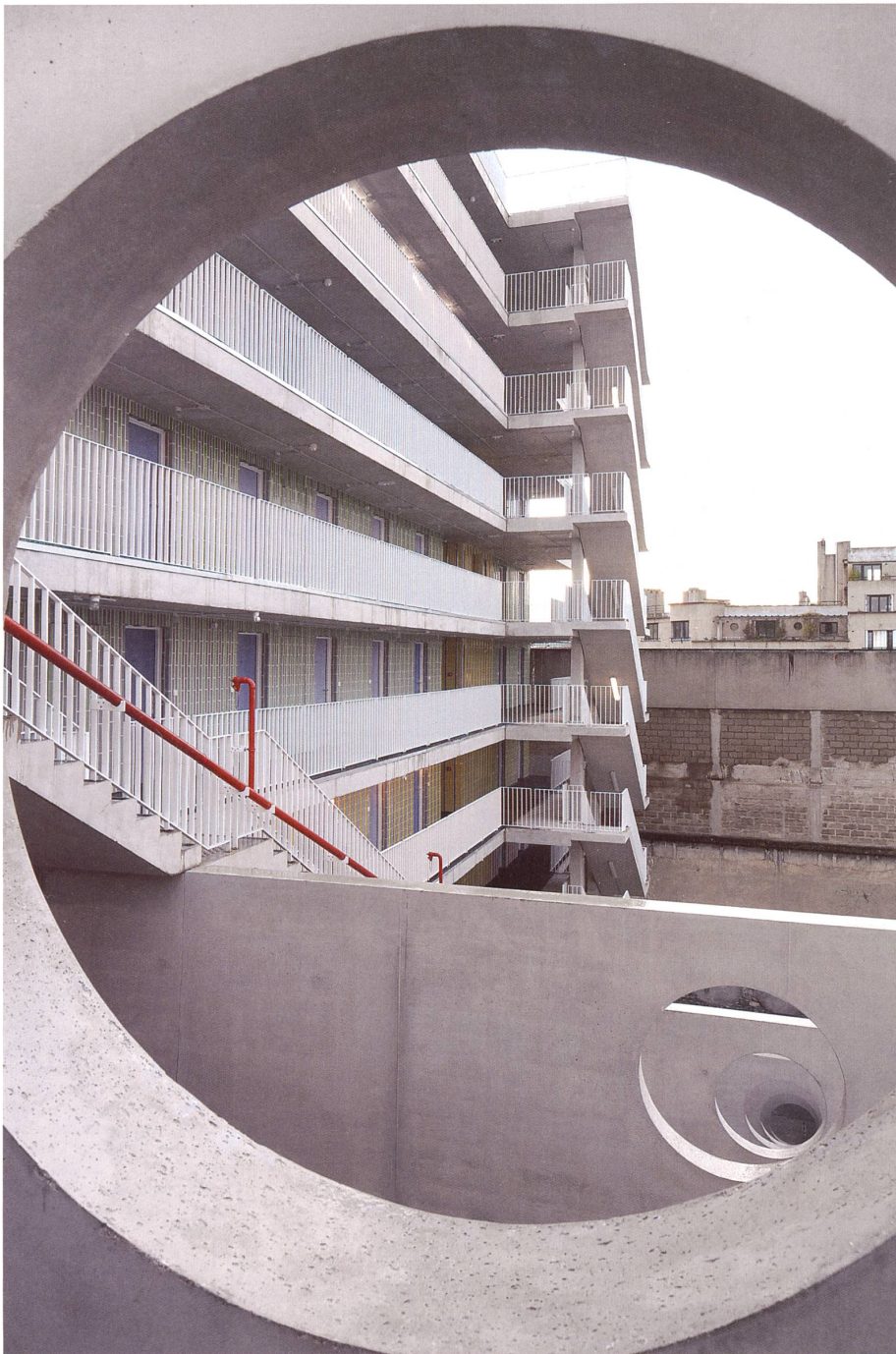
Jedem Gemeinschaftsraum ist eine Aussenterrasse zugeschaltet: Verbunden sind diese über die runde Öffnung, deren Mehrwert sich als kollektive Form zeigt, beim Durchblick in der Schräge.
