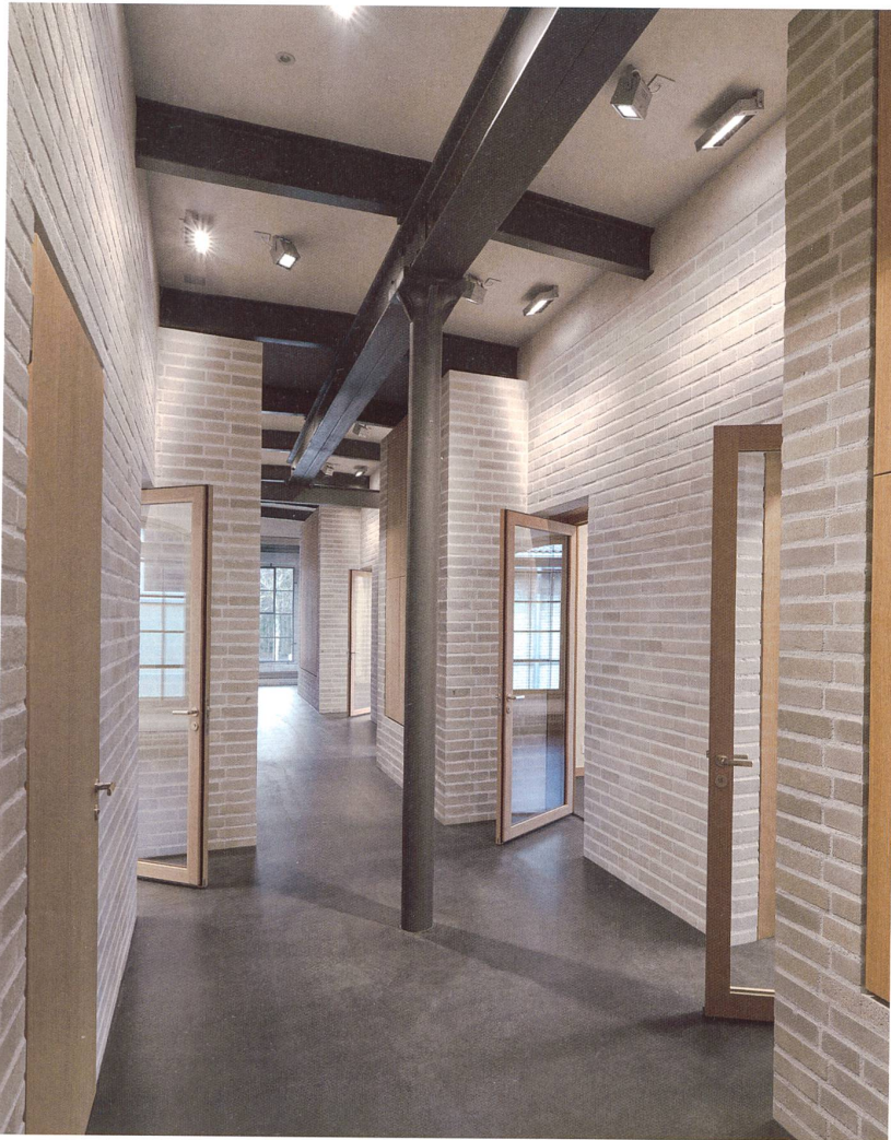
Neue und alte Ziegelschale sind an den Öffnungen erfahrbar. Bild: David Willen
