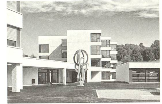
Marc Eigenmann Erweiterung Schulhaus Weidli, Uster, 2017 Allemann Bauer Eigenmann Architekten Zürich. Bild: Hannes Henz
