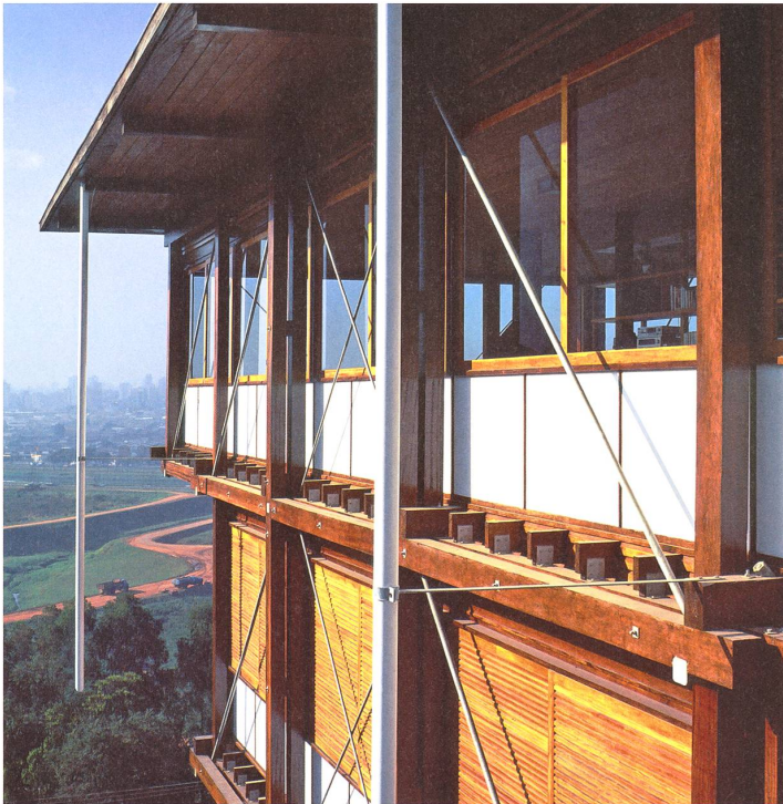
Sichtbar gefügt: Die Konstruktion ist als feingliedriges Relief an der Fassade ablesbar – geschützt durch Vordach und Auskragungen.
