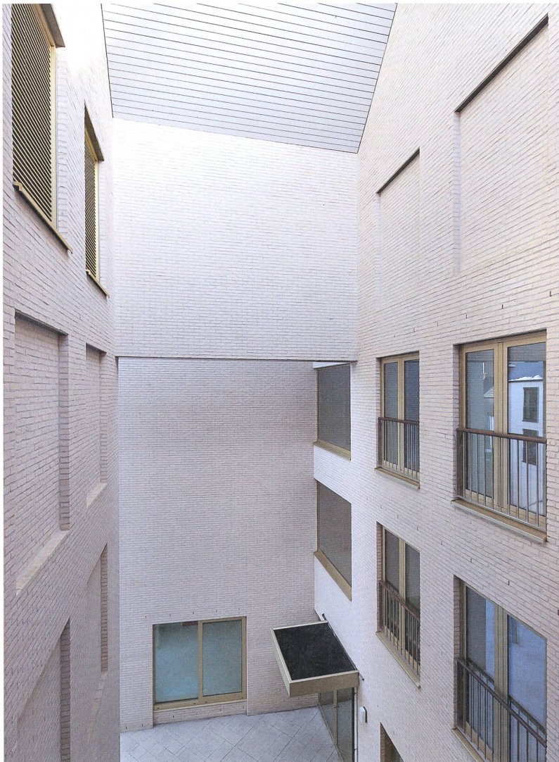
An der Gelenkstelle zweier Erschließungsflure sorgt ein mehrgeschossiger Luftraum für unerwartete Ausblicke und Lichteinfall. Bilder: Filip Dujardin
