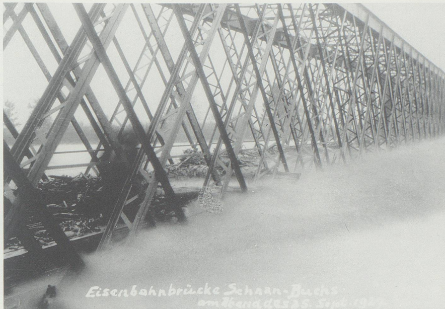
Die überflutete, mit Holz überführte Eisenbahnbrücke am späten Nachmittag des 25. Septembers.
