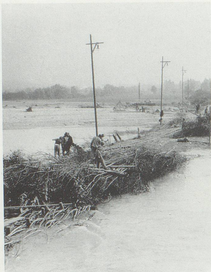
Um die Dammlücke zu schliessen, wurde vorerst ein Notdamm errichtet (schichtweise Lagen aus Querhölzern mit eingeflochtenen Erlenstauden und Kies).
