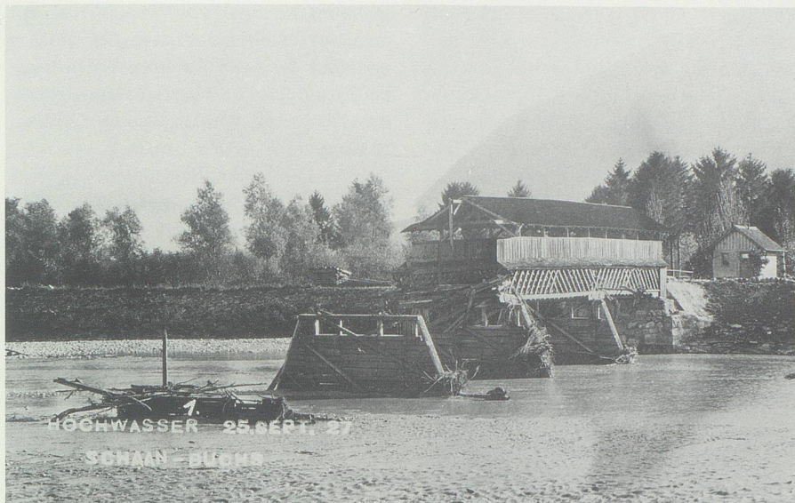
Nur ein kleines Stück der Buchser Brücke auf der Liechtensteiner Seite blieb stehen.
