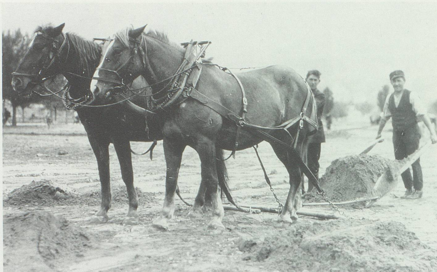
Räumungsarbeiten mit einer Pferdeschleppschaufel auf den ehemals schönen Feldern zwischen Schaan und dem Rhein.
