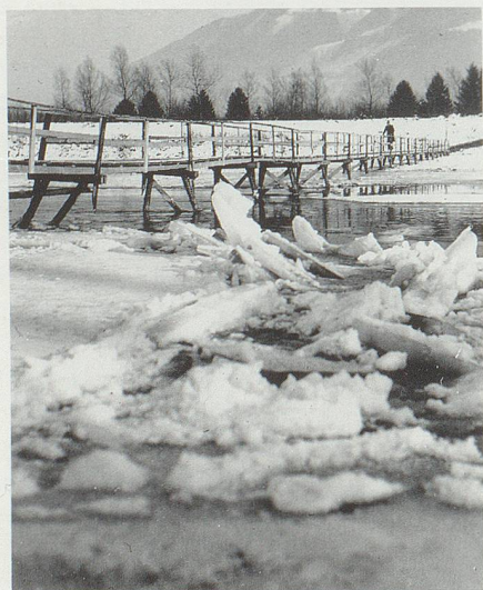
Der provisorisch errichtete Notsteg im Dezember 1927.
