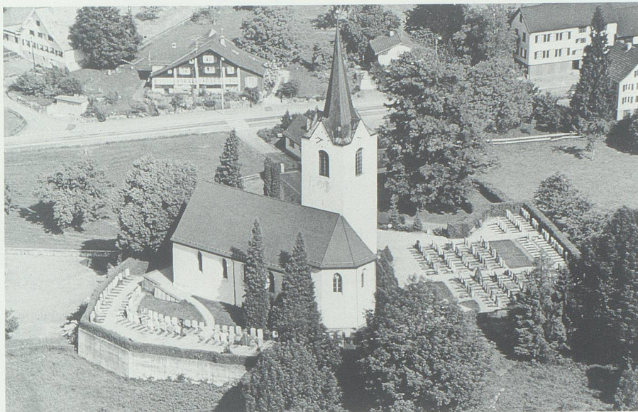
Gesamtansicht vor der Restaurierung von 1991. (Flugaufnahme 1987.)
