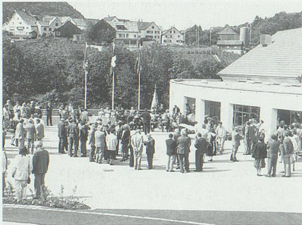
28.–30. Juni: Gross ist die Gäste- und Besucherschar an der feierlichen Einweihung der neuen Mehrzweckhalle Pradarossa, Oberschan.
