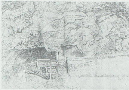
Eine Detailstudie Hackaerts aus Tafel 22 zeigt sehr schön die Strassenbau-technik mit Halbgalerien, holzgestützter Fahrbahn und Schutzvorrichtungen gegen Steinschlag in der Via Mala.
