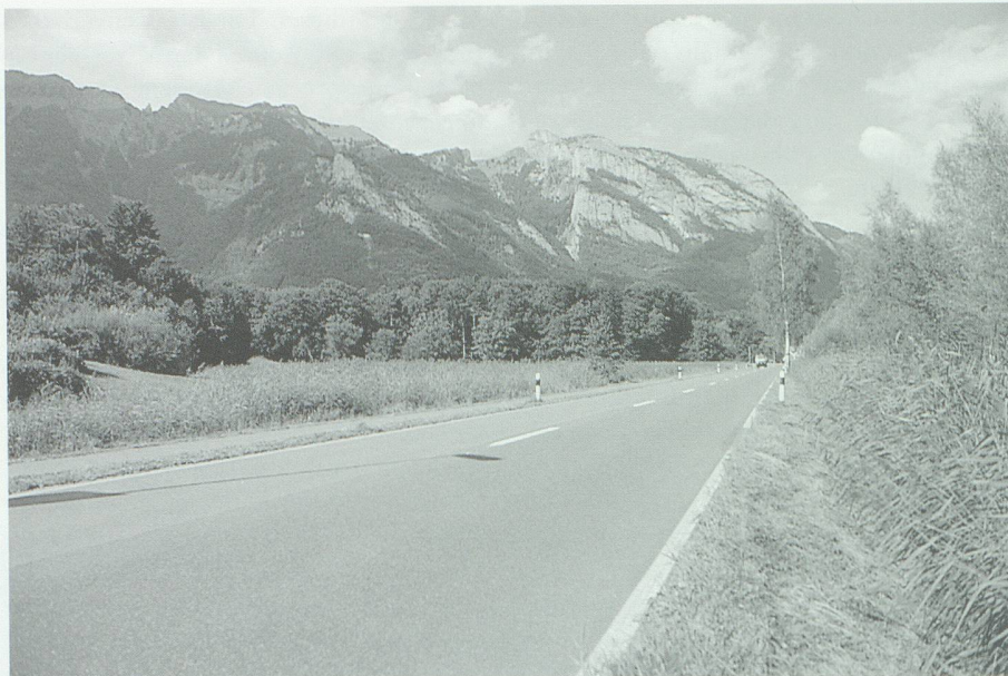
Abb. 22. Besondere Schwierigkeiten brachte beim Bau der Kantonsstrasse das Moorgebiet zwischen Salez und Sennwald (Burstriet): Das Trasse versank; das kaufmännische Directorium schoss zur Finanzierung der Mehrkosten Geld nach. Bild 1996: Hans Jakob Reich, Salez.
