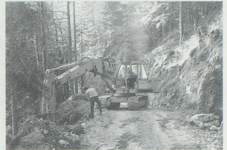
Beim Bau der Hübschenwaldstrasse 1988 in Sax.
