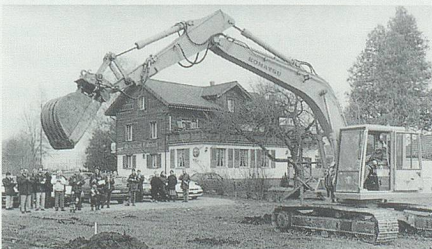
29. Januar: In Sevelen wird mit dem Bau der SBB-Unterführung begonnen.
