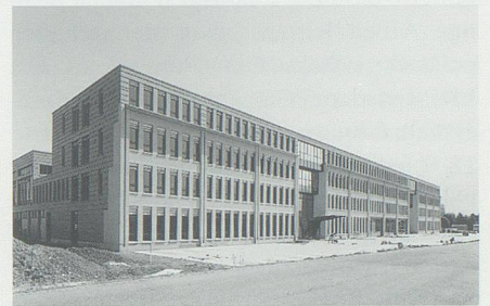
12. Juni: Die Pago AG weicht in Grabs ihren für rund 43 Millionen Franken errichteten Neubau ein.
