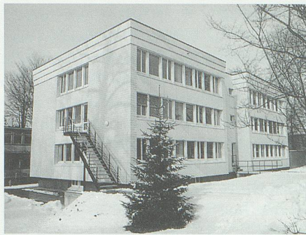
9. April: Die Acima AG in Buchs kann einen Büroneubau in Betrieb nehmen.
