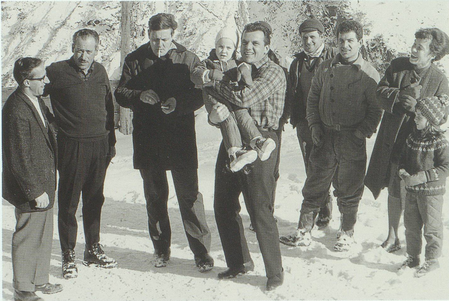
«Ich war mit meinen blauen Augen sozusagen das Gschänggli für die Emigranten.» Curnera-Baustelle, Barbaratag 1965. Bild: Walter Rist.
