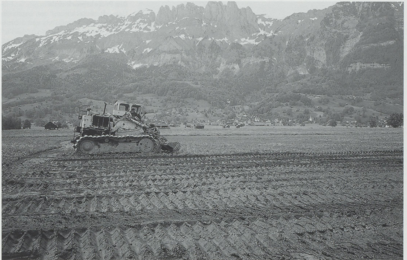
Für das Abtragen der nährstoffreichen obersten Humusschicht kam ein schweres Kübel-Raupenfahrzeug zum Einsatz. Das Abhumusieren schafft günstige Voraussetzungen für die längerfristige Wiederherstellung von Riedflächen.
