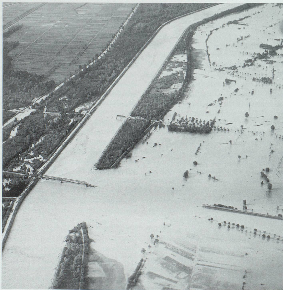
Die Dambruchsstelle einen Tag nach der Katastrophe: Der grösste Teil des Wassers ergiesst sich durch die rund 300 Meter lange Dammlücke in die Talebene; der Bahndamm ist zerstört. Bild aus Rheinnot 1977.
