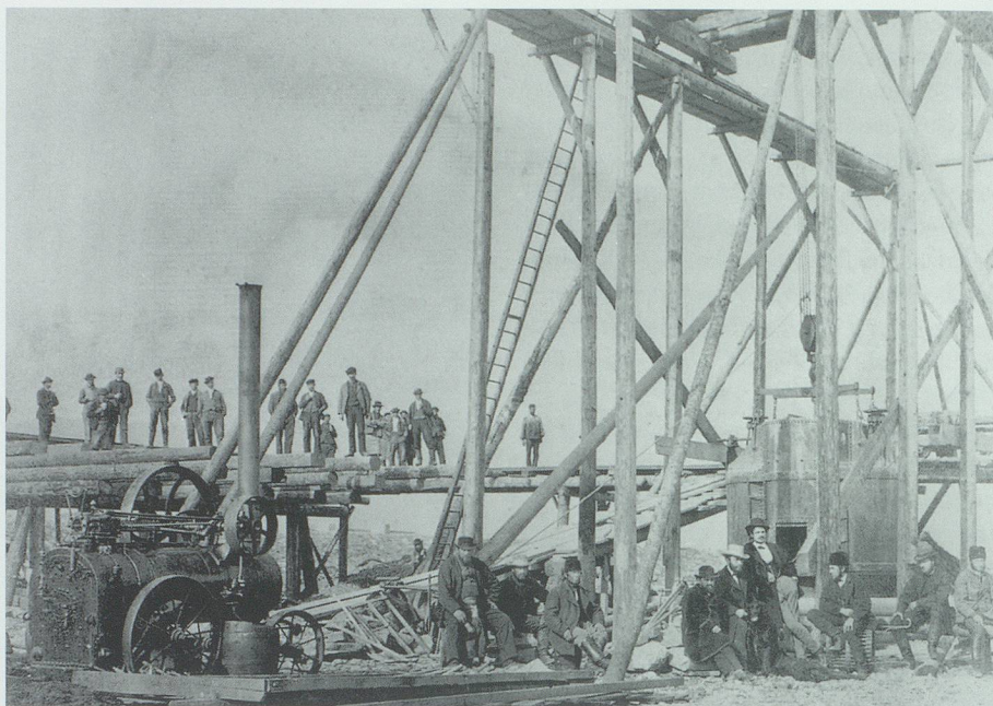
Beginn der Bauarbeiten für die Eisenbahnbrücke Schaan-Buchs um 1871. Bild aus Beer 2000.
