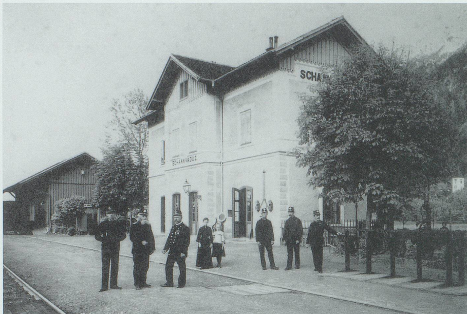
Das Aufnahmegebäude der Station Schaan-Vaduz nach der Aufstockung um 1891. Bild aus Beer 2000.
