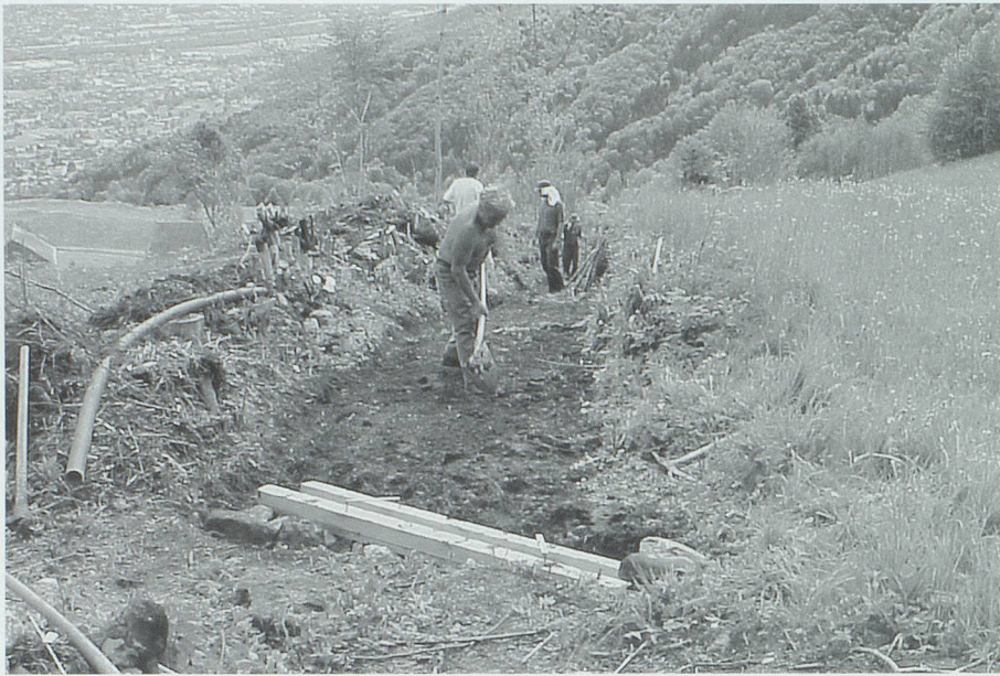
Vor dem Wiederaufbau der seitlichen Stützmauern im Projektabschnitt an der Buechengass wurde die Wegsohle auf einer Länge von 240 Metern in Stand gesetzt. Diese Arbeit übernahmen Angehörige des Grabser Zivilschutzes. Bild 2000: René Hitz, Grabs.
