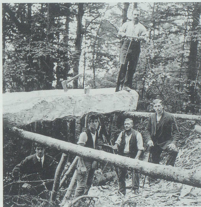
Noch in den ersten Jahrzehnten des 20. Jahrhunderts wurden Balken für den Bau von Alpgebäuden im nahe gelegenen Bergwald in anstrengender Handarbeit zugelegt, wie dies das Bild aus den 1920er Jahren dokumentiert. Es entstand anlässlich des Baus des Rieter Scherms im Rieterwald/Cholplatz (Gemeinde Wartau). Oben an der Säge Hans Heeb, Zimmermann, unten an der Säge rechts Jöri Schlegel und links Emil Caprez; ganz rechts (mit Stock) Baumeister Hans Schmidt. Bild in Privatbesitz.
