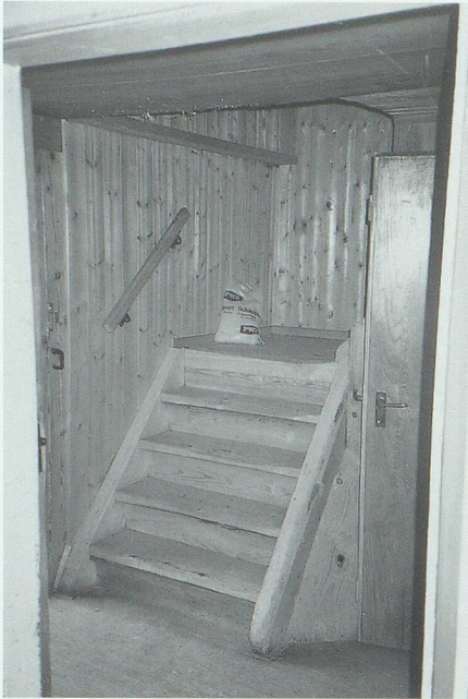
Diese Treppe (Bild links) ist etwas steil, und die Treppenkanten sind massiv ausgelassen. Die neue Treppenkonstruktion (rechts) weist ein ideales Treppenverhältnis auf.
