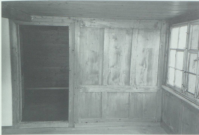
Wegen der veränderten Raumhöhe wird das Stubentäfer neu erstellt, aber in gleicher Konstruktionsart wie früher.
