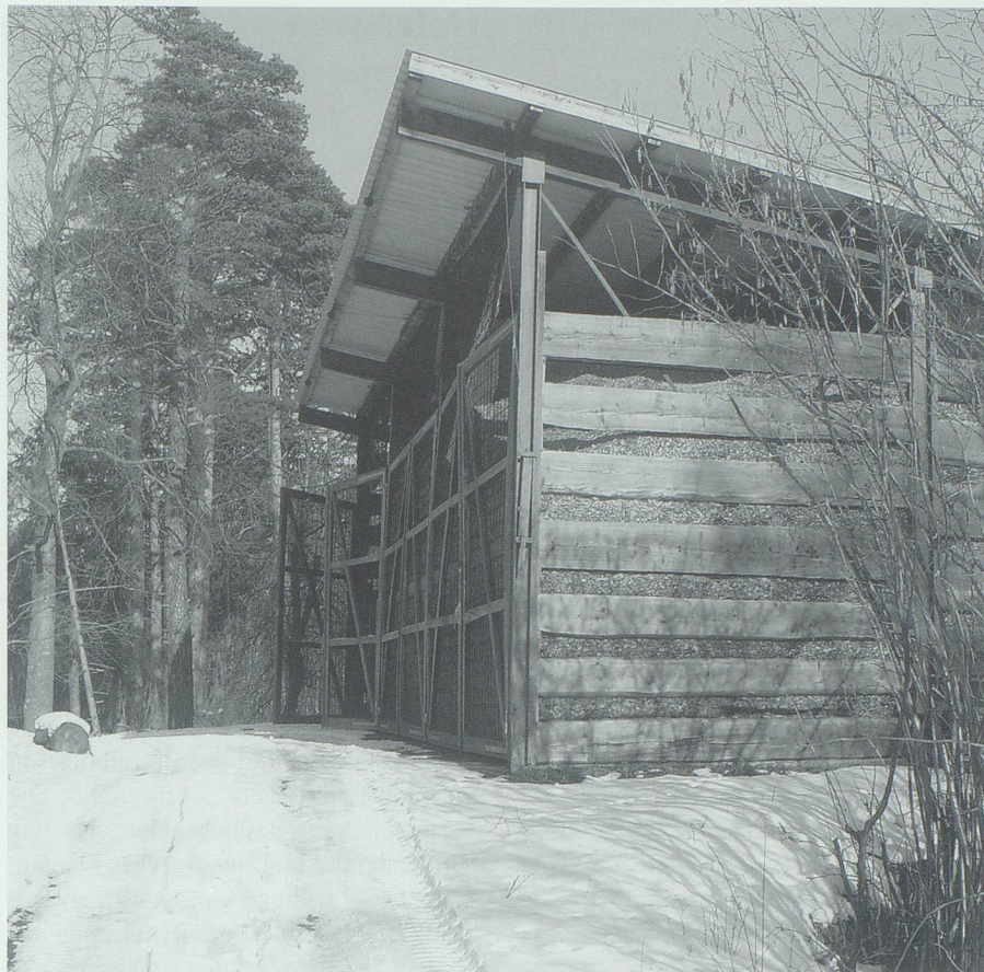
Die Holzschnitzel-Lagerhalle der Ortsgemeinde Wartau beim früheren Wasenplatz weist ein Volumen von 450 Kubikmetern auf und dient als Pufferlager.
