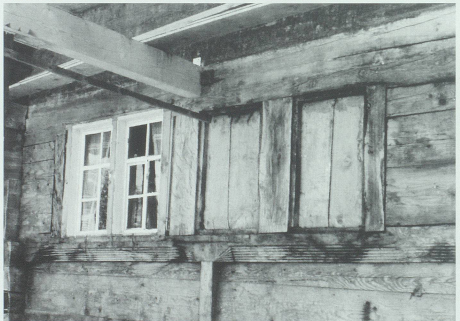
Zwei zugeschaltete Fenster der Nordwestfront werden wieder geöffnet. Bild 1985 (ebenfalls das Bild rechts): Franz Wildhaber, Flums.
