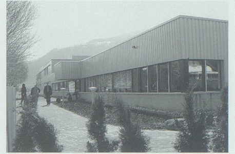
14. März: Mit ihrem Erweiterungsbau hat die Dividella AG in Grabs die Nutzfläche des Betriebs mehr als verdoppelt.
