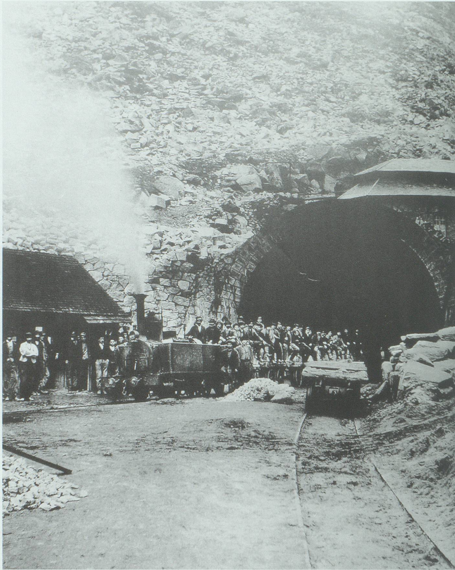
Der Gotthardbahn-Bau mit Arbeitern auf der Nordseite bei Göschenen, um 1880. Kreis 1997, S. 383
