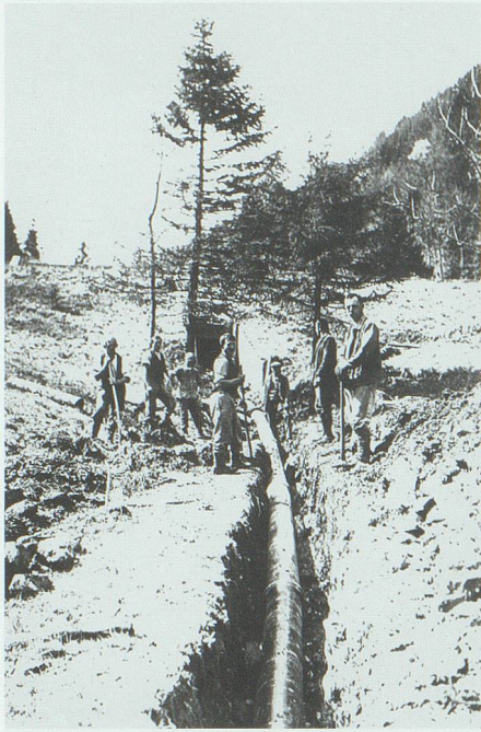
Anschluss der Druckleitung an den Stauweiher Fuchser, 1932. Von links: Hans Ruosch, Veltur; Bernhard Litscher (Bühl Bernhard); Andreas Ruosch, Pfäfers (Platta Heiris); Mathias Engler, Glathalde; Hans Tischhauser-Müller, Välsli (Blina Hans); Gustav Farner, Betriebsleiter; Jakob Vils, Pfäfers. Sammlung Werner Hagmann, Zürich
