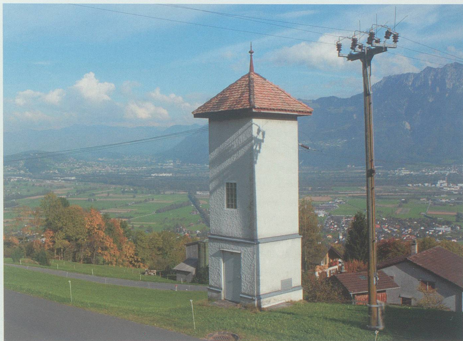
Das 1918 errichtete «Transformerhaus aus Ziegeln und armiertem Beton an der Halde» dient auch heute noch der Versorgung des Grabserberges mit elektrischer Energie. Foto Hans Jakob Reich, Salez
