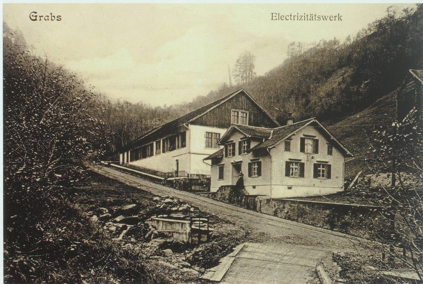
Im Gebäude der früheren «Löchli-Fabrik» wurde 1899 der Maschinensaal des Elektrizitätswerks Grabs eingerichtet; das Wohnhaus diente als Maschinistenwohnung. Aufnahme um 1900. Archiv Hansruedi Rohrer, Buchs
