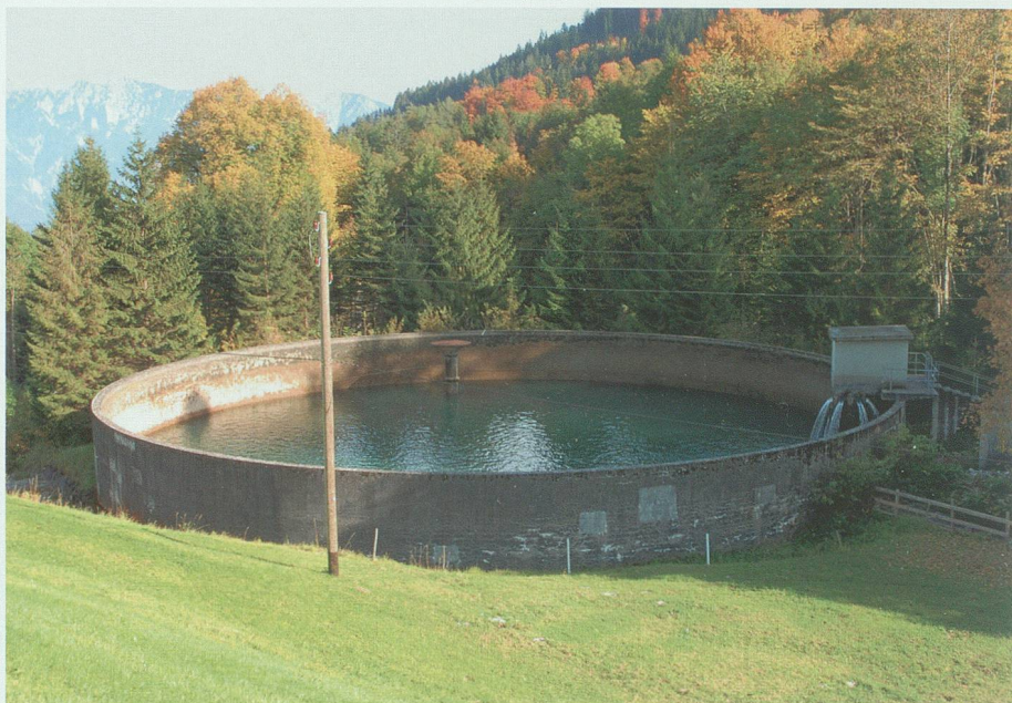
1958/59 erstellte das Elektrizitätswerk Grabs beim Rogghalm das 1500 Kubikmeter fassende Reservoir und baute die Gefällstufe Rogghalm–Banwald aus. Foto Hans Jakob Reich, Salez
