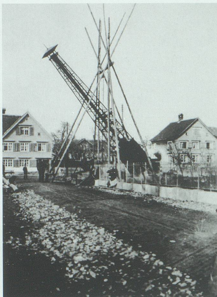
Montage eines Transformermastes im Jahr 1903 bei der Einmündung der Schulhausstrasse in die St.Gallerstrasse.
