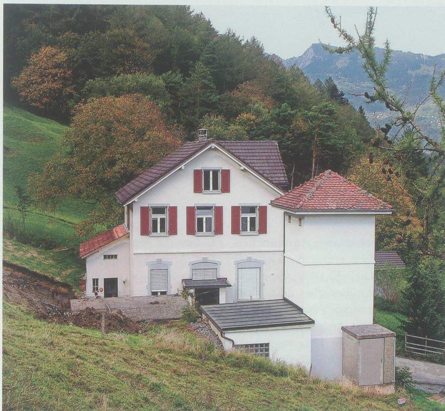
Das Maschinenhaus Azmoos mit dem Transformerrhäuschen: 1908 liefen hier zwei Maschinengruppen mit je 60 PS Leistung, die 1926 um eine Gruppe mit 150 PS Leistung ergänzt wurden. Foto Hansjakob Gabathuler, Buchs
