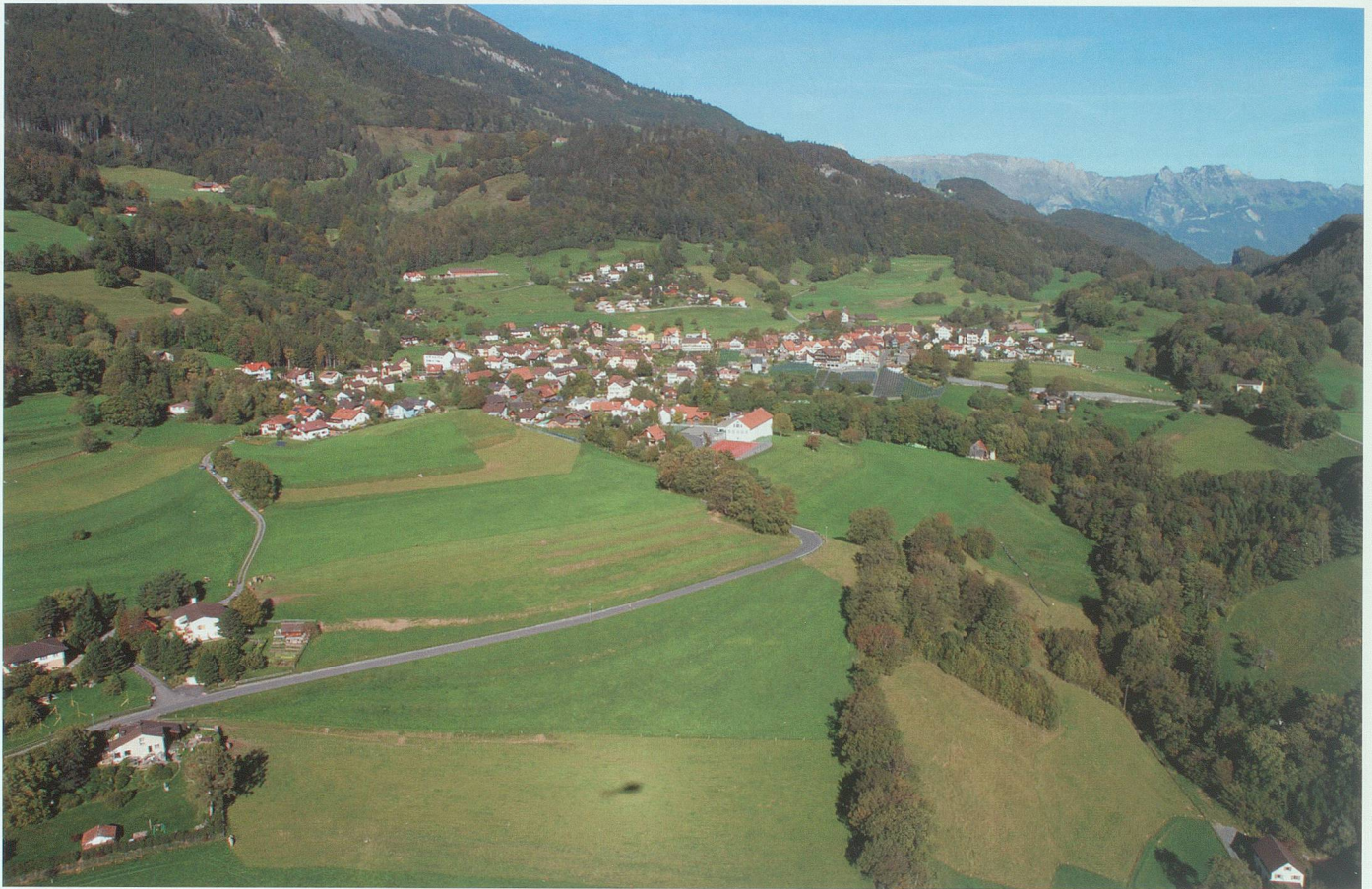
Links hinter der Sportanlage Oberschan füllt das Wasser des Mülbachs das Reservoir. Die Druckleitung führt über Mülibünt und Pradarossa zum Maschinenhaus im Tobel rechts unten im Bild. Luftaufnahme 2006 Hans Jakob Reich, Salez
