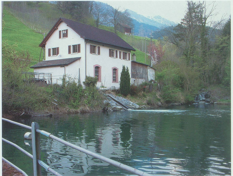
Das Maschinenhaus im Tobel: Das von den Turbinen austretende Wasser füllt gemeinsam mit dem Restwasser des Mülbachs den daneben liegenden Weiher für die Elektrizitätsversorgung der ehemaligen Weberei Azmoos. Die Freileitung führt über Pradarossa zum Dorf Oberschan. Foto Hansjakob Hanselmann, Oberschan
