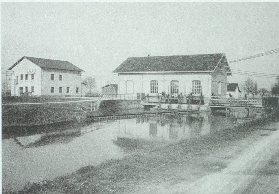
Zentrale Montlingen der Binnenkanalwerke mit (links) Unterstation, um 1915. Elser 1940, S. 33
