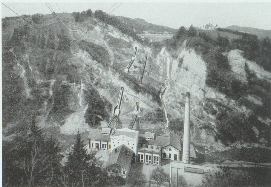
Das Elektrizitätswerk Kubel im Zustand von 1908 mit den Druckleitungen und (oben) der Staumauer am Gübsenweiher. Elser 1940, S. 29
