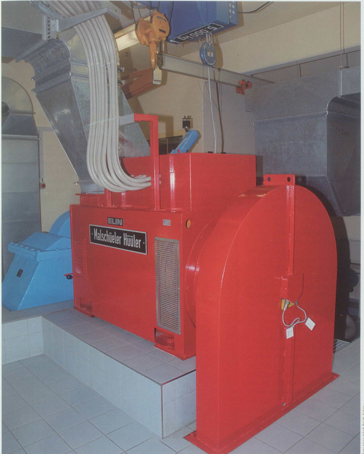
EWB-Kraftwerk Vorderberg/Buchs: 1000-kW-Synchrongenerator «Malschüeler Hüller».
