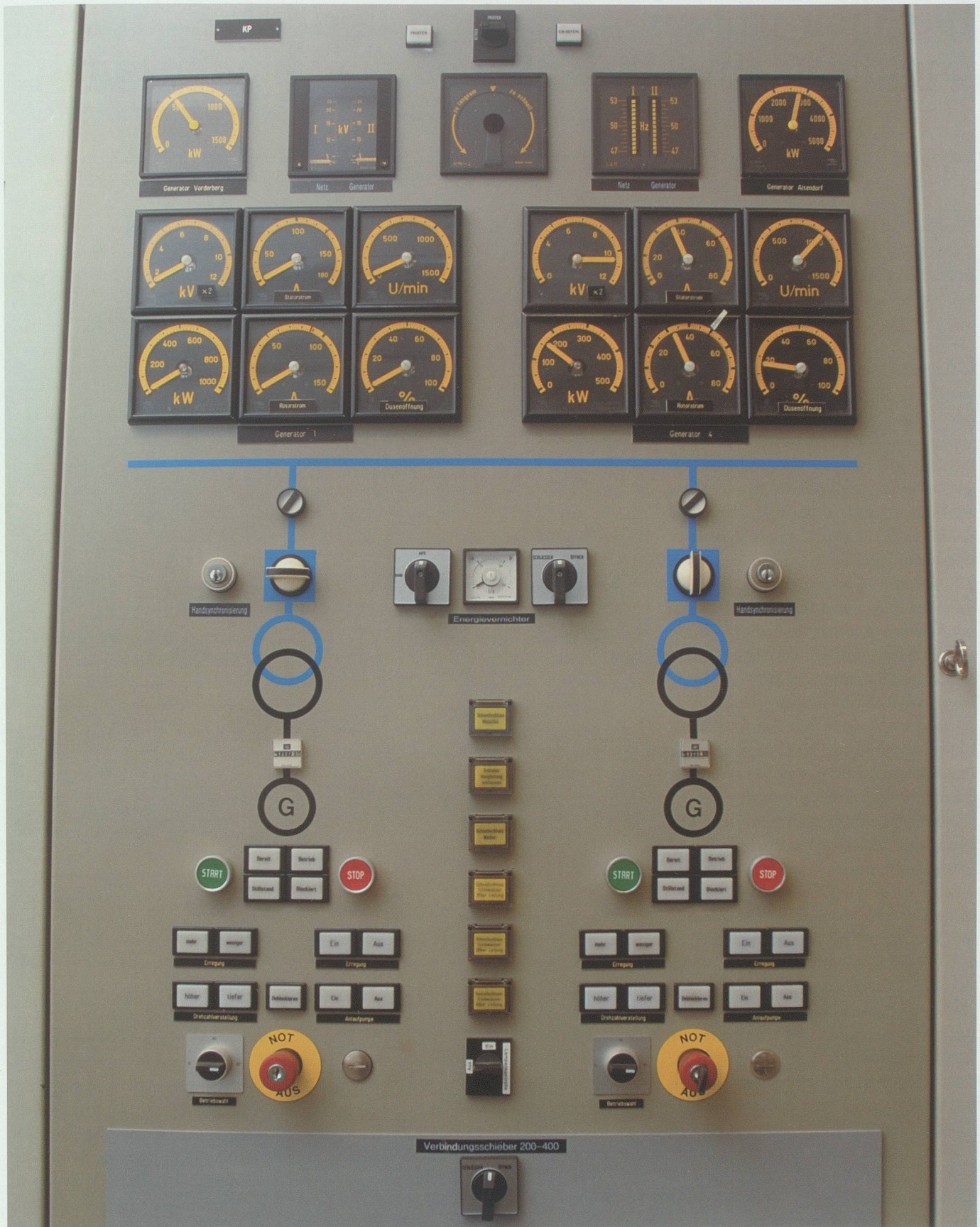
EWB-Maschinenhaus Tobelägerli/Buchs: Kommandotableau «Zählung/Registrierung».
