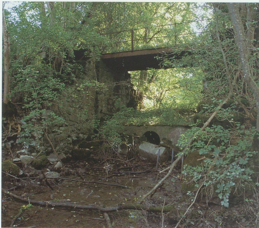
Ein vergessener und verfallender Zeuge der Geschichte: Das Überleitungsbauwerk (mit Wegbrücke) am Übergang des einstigen Kolmationsabwasserkanals in den alten Mündungslauf besteht bis heute. Die Tschodere, das einstige «Schwimmbad» der Salezer, ist allerdings zur Abfallgrube verkommen. Foto Hans Jakob Reich, Salez
