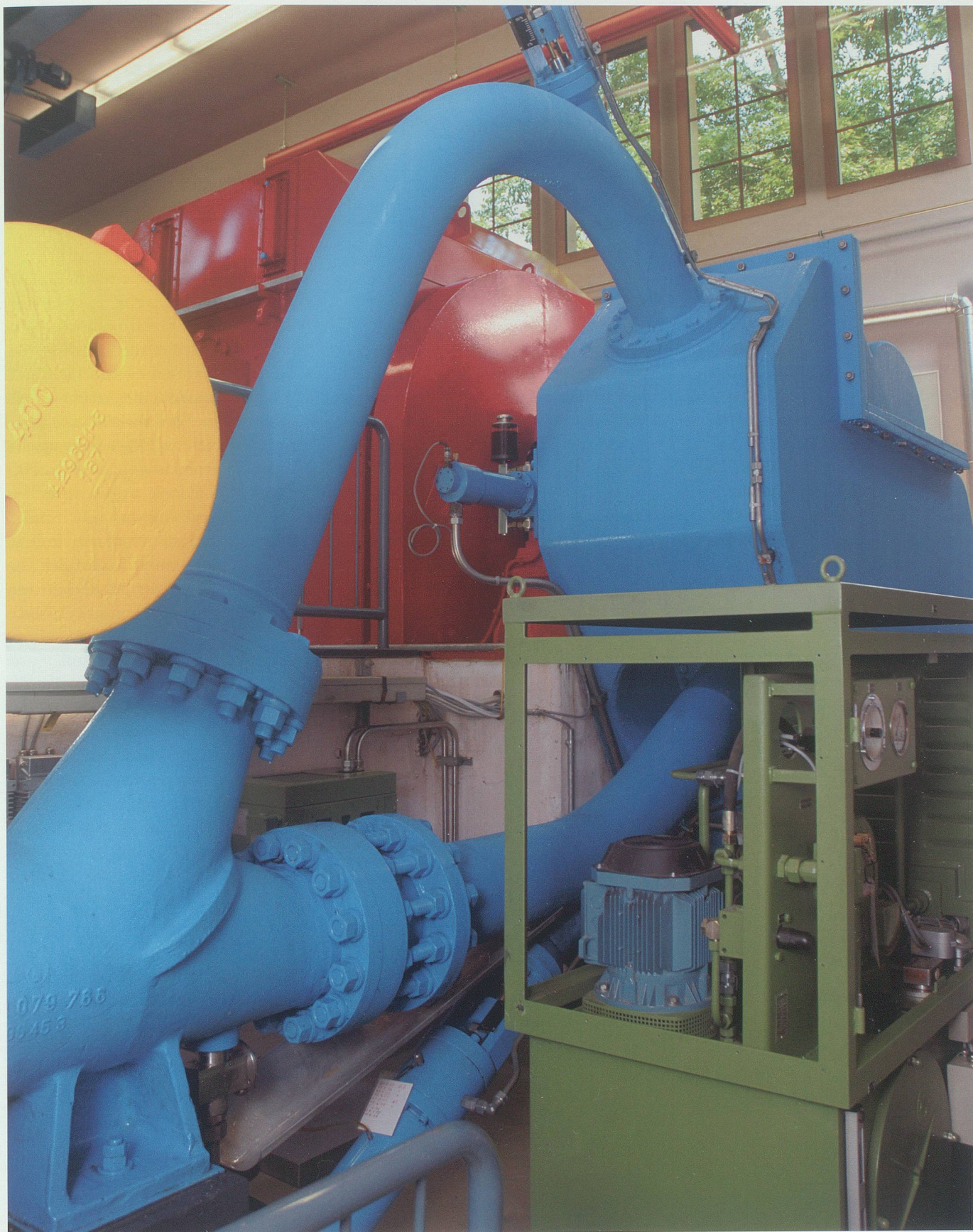
EWB-Zentrale Altendorf/Buchs: 3800-kW-Generator Jahrgang 1988 mit zweidüsiger Wasserzufuhr aufs Turbinenrad.
