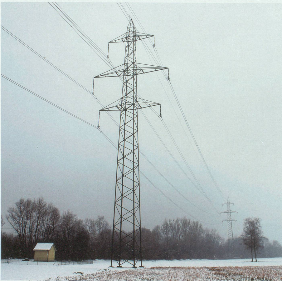
Fast ganz Europa ist heute auf der Höchstspannungsebene verkoppelt. 220-kV-Leitung der NOK; links das Grundwasserpumpwerk der Dorfkorporation Salez. Foto Hans Jakob Reich, Salez
