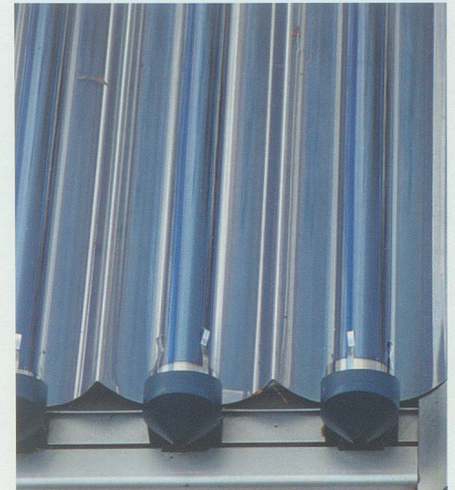
Mit Solarabsorbern (im Bild ein moderner Vakuumröhrenkollektor) lässt sich viel elektrische Energie sparen. Soltop
