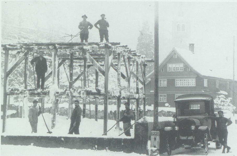
Als Kühlmittel bei der Bierherstellung und -lagerung wurde zu Beginn des 19. Jahrhunderts noch Natureis verwendet. Es wurde entweder aus dem gefrorenen Werdenbergersee gewonnen oder mittels sogenannter mit Wasser berieselter Eisgalgen produziert (Bild links) und in die Brauerei (rechts) und Keller transportiert. Archiv Hansruedi Rohrer, Buchs
