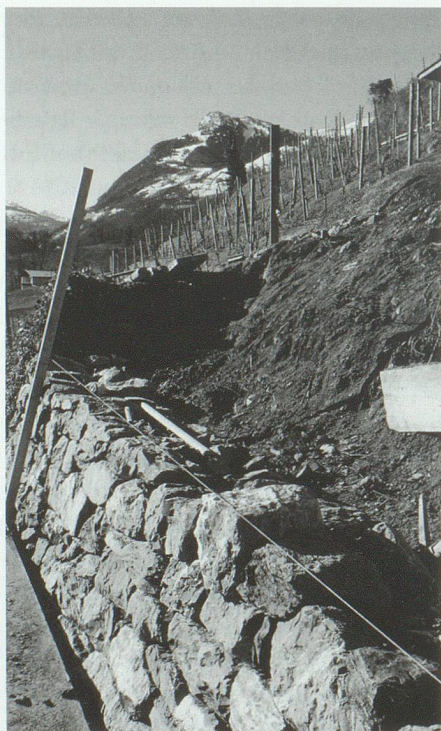
20. Januar: Die Sanierung von Trockenmauern in Wartau wird aus dem Konjunkturpaket des Bundes unterstützt.
