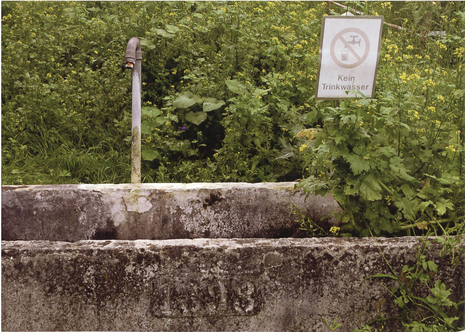
Das Schild «Kein Trinkwasser» muss an Brunnen angebracht werden, deren Wasser nicht regelmässig – wie für öffentliche Wasserversorgungen vorgeschrieben – auf Trinkwasserqualität überprüft wird. Foto Hans Jakob Reich, Salez
