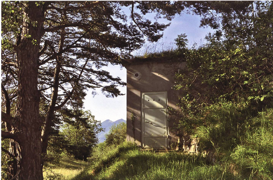
Das Reservoir der Dorfkorporation Gretschins-Fontnas (DKGF) steht seit 1959/60 auf Ferfiggs, hoch über dem Weiler Gretschins.
