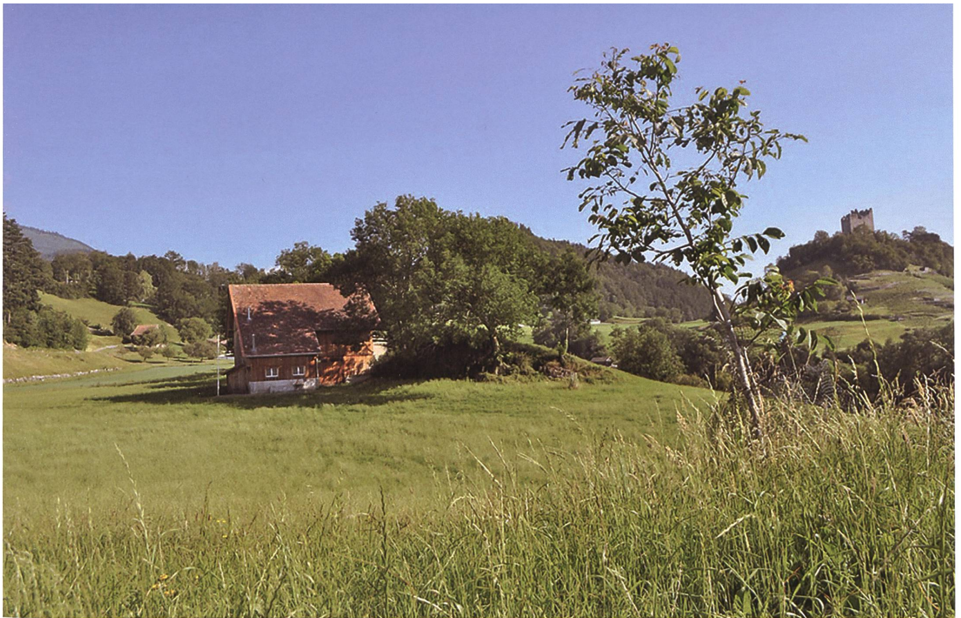
Vor der Scheune auf Gapluem verläuft die Wasserleitung von Ferfiggs her (dem Hügel im Hintergrund links) über Gretschins nach Fontnas und in einer Abzweigung zum Reservoir der Dorfkorporation Weite in Girangga/Ferschlinis.
