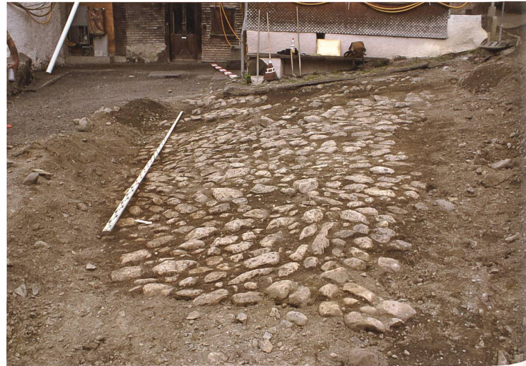
Abb. 8: Pflasterung im Bereich des Schlangenhauses.
