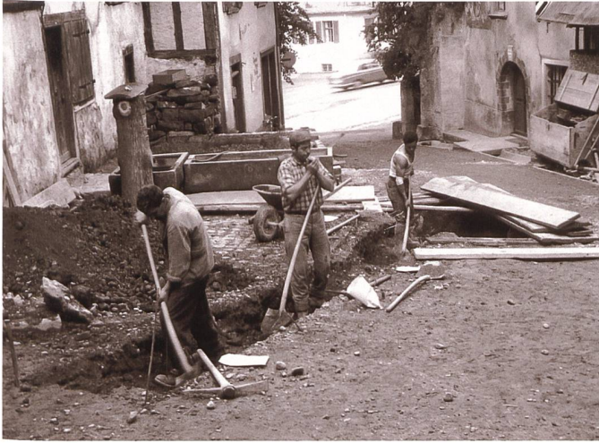
Abb. 2: Werkleitungssanierung im Städtli im Jahr 1961, in deren Rahmen archäologische Funde gemacht wurden.
