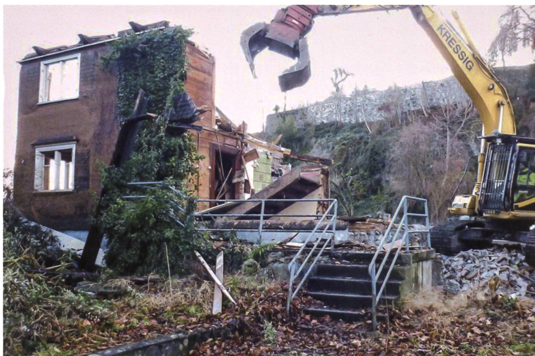
Mitte Dezember 2019: Das alte Biedermeierhaus neben der evangelischen Kirche wird abgebrochen.
